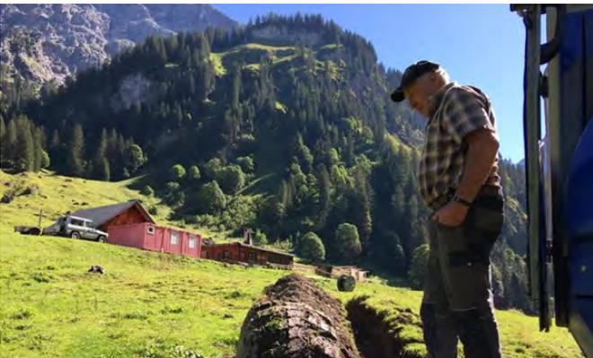
Mit der Stromleitung wurde auch eine Wasserleitung von der Oberen Hutla zur Unteren Hutla (2,8 km Leitung) eingelegt.
