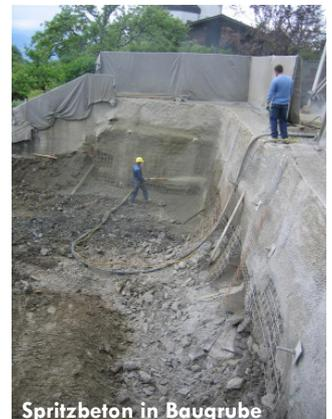
Spritzbeton in Baugrube
