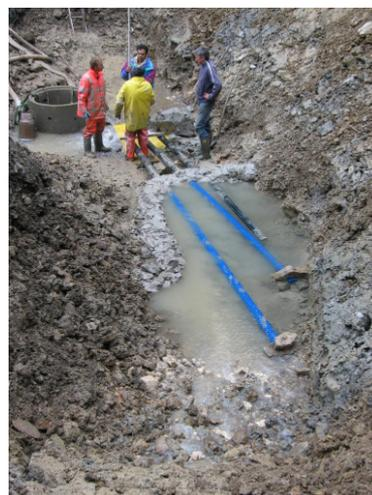
mit der Schaufel in der Baugrube bei der eigentlichen Quellfassung. In der Folge wurde die Verwurflung vom Quellsammelschacht zum Fallersbach verlegt. Dann wurde der nach Maß vorgefertigte Quellsammelschacht gesetzt und die 4 Fassungsleitungen dort einge-
