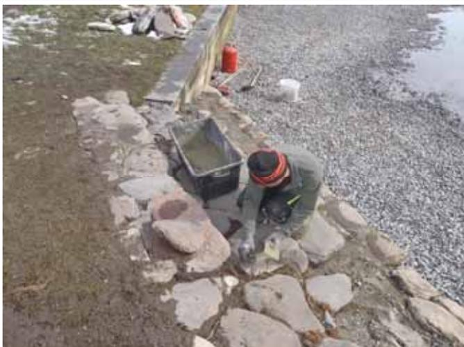
Die Stufen der Zugangstrepfen wurden neu befestigt und die Ufermauern gereinigt.
