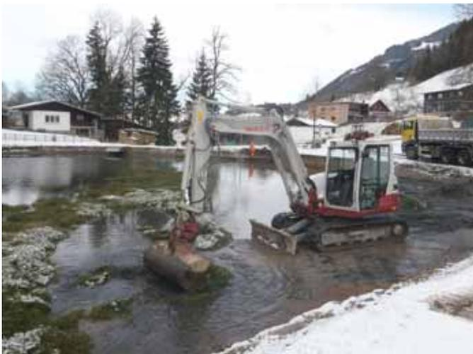
In einem nächsten Schritt wurden Algenbewuchs und Schlamm im Badebereich ausgebaggert und ca. 24m<sup>3</sup> Rundkorn-Kies eingebaut.
